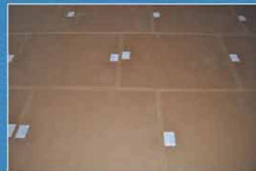
Reihen versetzt verlegen um Kreuzfugen zu vermeiden
