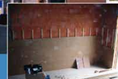
PhoneStar an der Wand
