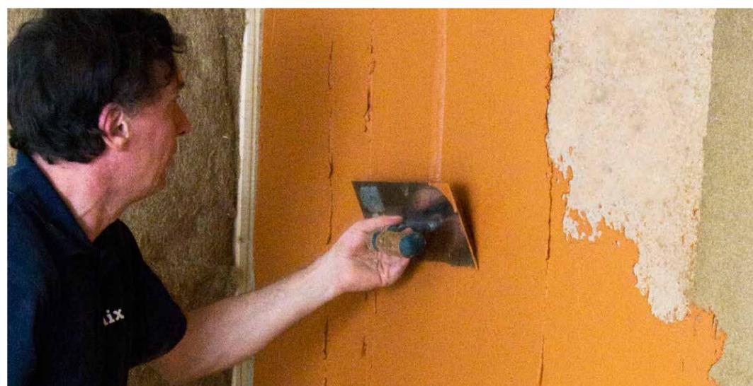
im Fugenbereich nach dem vollständigen Trocknen mit einem Flächenschleifgerät (z.B. Giraffe) abgeschliffen.
