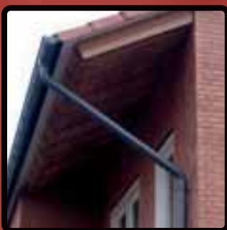
5. Overturenlaan Krimpen aan de IJssel 150 mm goot 75 mm buis ( 07 zilvermetallic )
