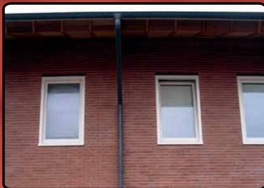
5. Overturenlaan Krimpen aan de IJssel 150 mm goot 75 mm buis ( 07 zilvermetallic )
