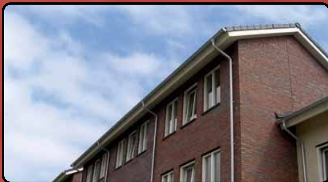
5. Overturenlaan Krimpen aan de IJssel 150 mm goot 75 mm buis ( 07 zilvermetallic )
